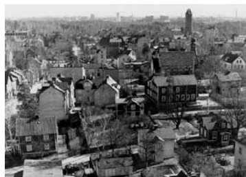
Den indbydende småhusbebyggelse, 'kåkstaden' måtte 1965 vige pladsen for det rationelle byggeri, i Solna, Hagalund.
