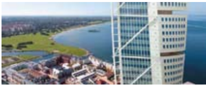
The Turning Torso, Malmø, 54 etager, 190 m højt.
